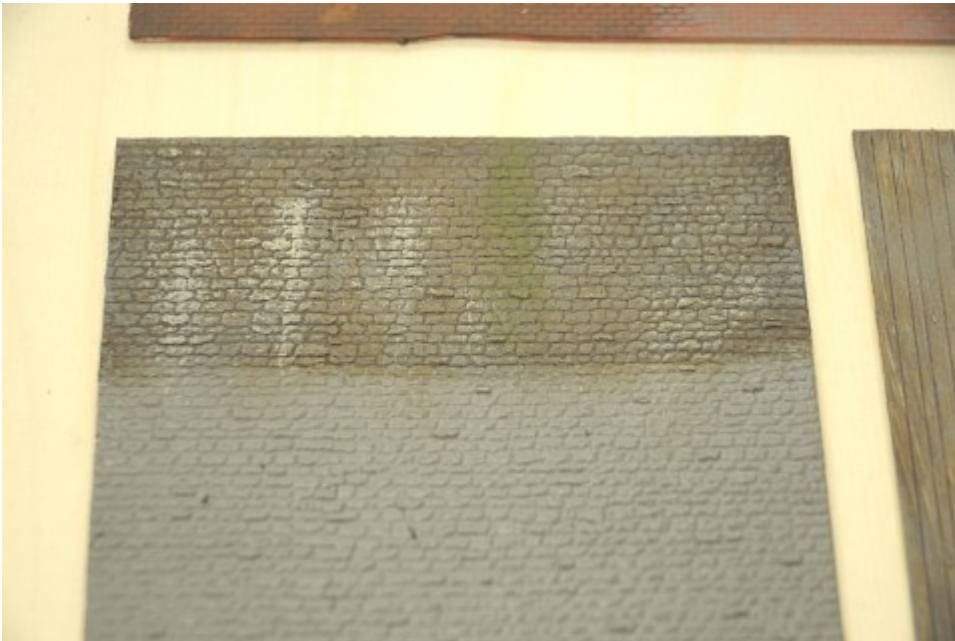
Die Bruchsteinmauer im oberen Teil mit Kalkauswaschung, Moos und Erd-/Sandverschmutzung. Unten ist der unbehandelte Teil zu sehen.
